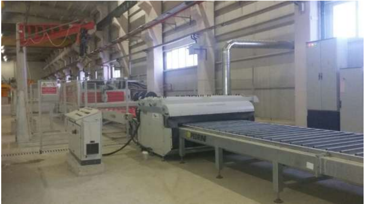
Bayburt Doğal Taş Fabrikası
